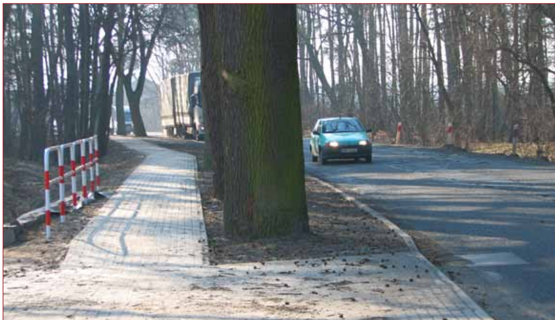
Chodnik został przesunięty za linię drzew, przez co ani jednego nie trzeba było wycinać. Jeszcze lepiej byłoby, gdyby przy budowie chodnika zastosowano techniki łagodzące jego wpływ na korzenie drzew. Jednak nawet bez tych kroków drzewa mają się dobrze. Fot. Piotr Tyszko-Chmielowiec
